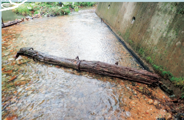
第4号水制工の完成
