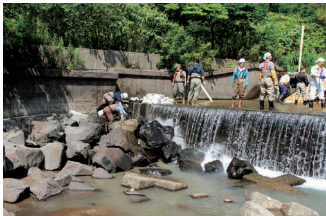
下流側の魚道 巨礫間の間詰め作業
