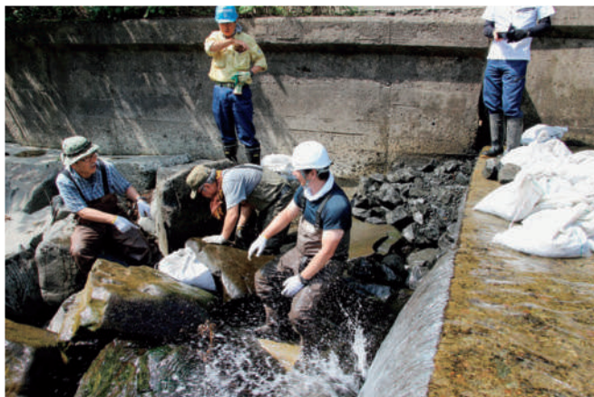
間詰めによる遡上水深の確保
