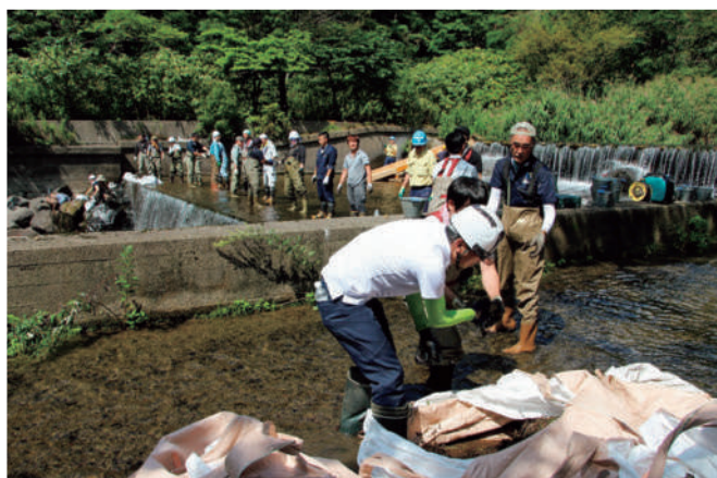
下流側の魚道 間詰め砂利の人力運搬 (1)
