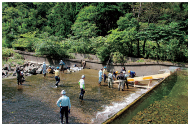
木製簡易魚道の設置 (舟通しタイプ)
