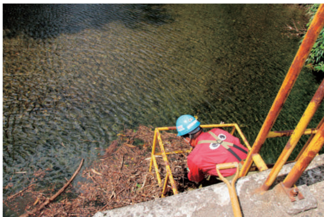
上流側の魚道 流入口の清掃 (2)
