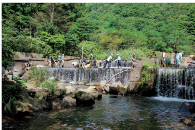
下流側の魚道 間詰め砂利の人力運搬 (2)
