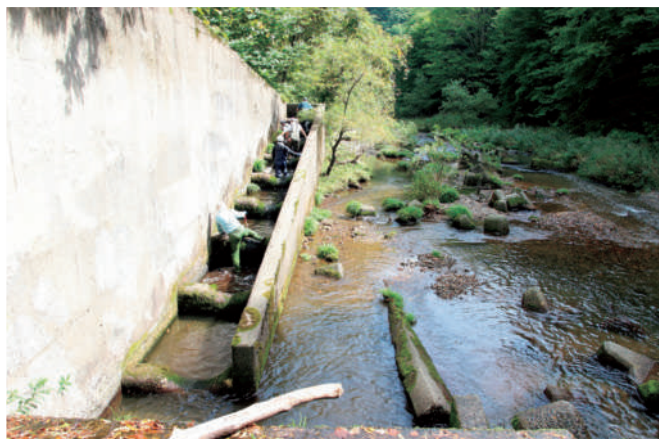
上流側の魚道 流入口の清掃 (1)
