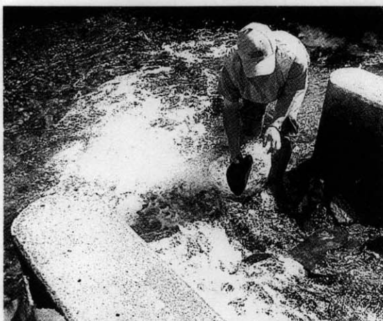
石を積み、水深を確保する一平会事務局の鎌田さん。土砂除去の取組も進めている。
