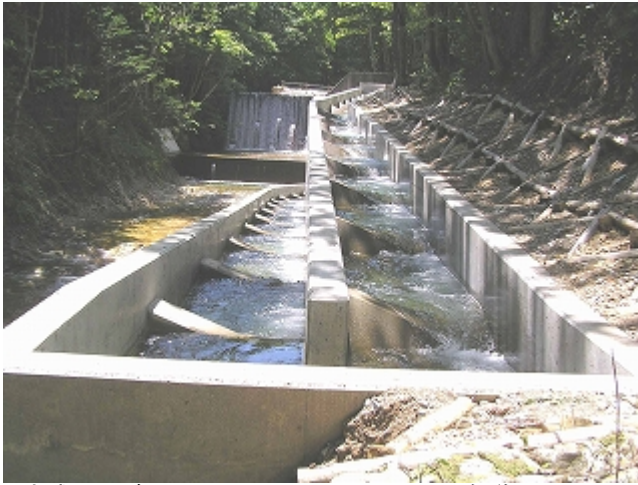
完成したばかりの川汲川 No.1 谷止め工魚道 プール間の隔壁に傾斜壁を採用し、越流天端も傾斜させるなど工夫が施されている
